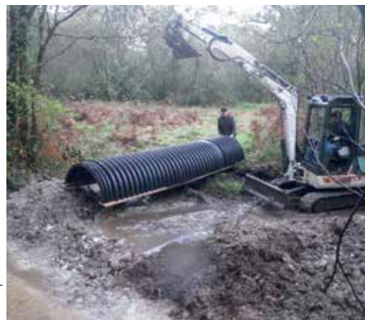
Arche de franchissement surmontée d'un empierrement en entrée de demi-buse.
